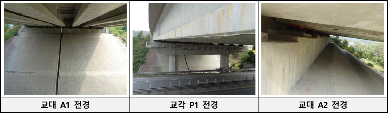
[교대 및 교각 전경]
